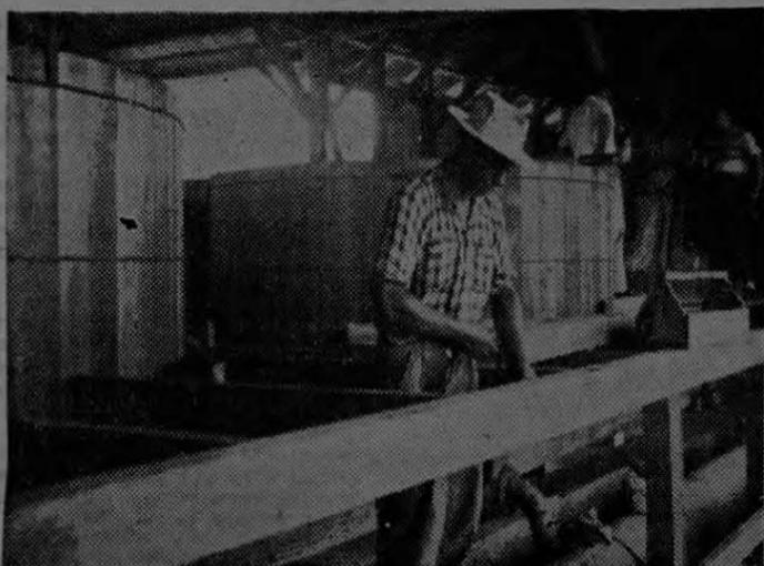
El carpintero Pastor Acevedo Acuña, termina de ajustar una pieza en la tarima que sostiene los grandes tanques de mezcla de caldo bordalés en las nuevas Fincas del Valle de Coto, 42 y 43. La instalación de estos tanques es indispensable para mantener la plantación libre de sigatoka.-
